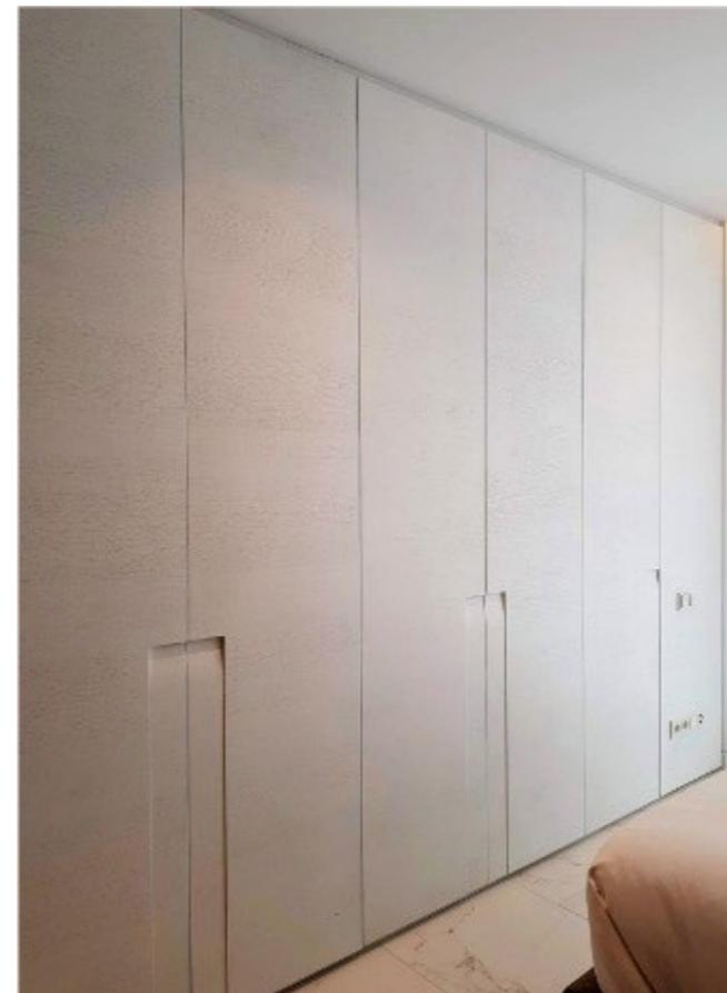
Armario modular compuesto por frente armario lacado en color blanco o similar, con hojas lisas de 300 a 600x(2030+807)x25 mm. de suelo a techo dejando holgura de 5 mm. con ambos, enrasadas hojas con tapajuntas liso de 70x12 mm. ,bisagras de cierre automático amortiguado y apertura por gola pantografiada.
